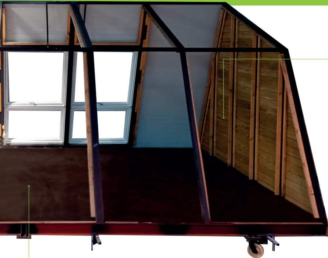
**SUELO Y AISLAMIENTO INFERIOR.** El aislamiento de la parte inferior (suelo) de las cabañas está reforzado mediante planchas de EPS (Poliestireno expandido) apoyadas en la IP, dejando una cámara a su vez entre éstas y el tablero de alta resistencia donde se fija el suelo.
