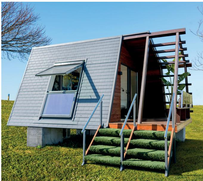
Modelo 6x4,5 con apoyos sobre zapatas de hormigón
